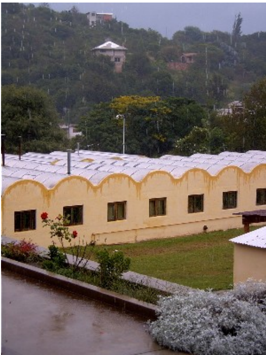
EMPI-Gelände bei Regen
